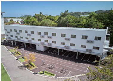
完成したクラブハウス
