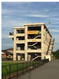
津波避難タワー
