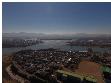
ドローンによる大湊空撮
