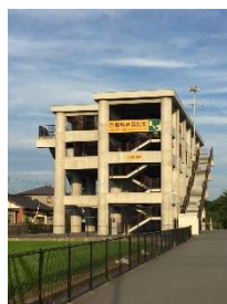
津波避難タワー
