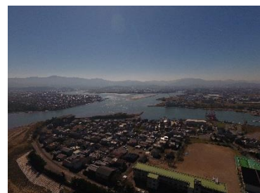
ドローンによる大湊空撮
